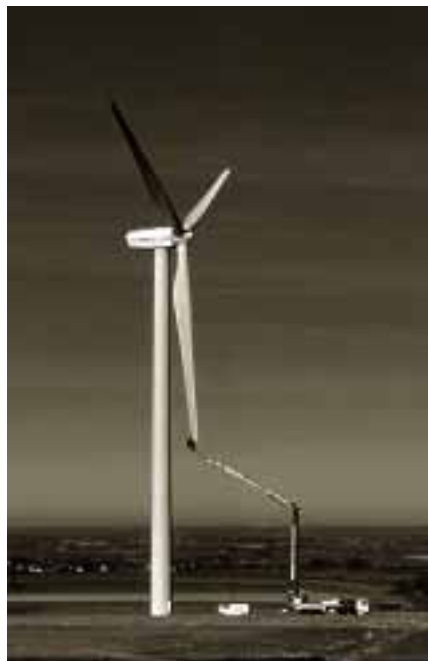
Rotorblatt-Reparatur an der Enron 1.5s der BürgerWIND Bördeblick.
