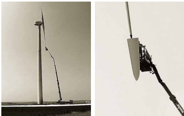
Im Windpark Dautenheim wurden die Rotorblätter repariert.
