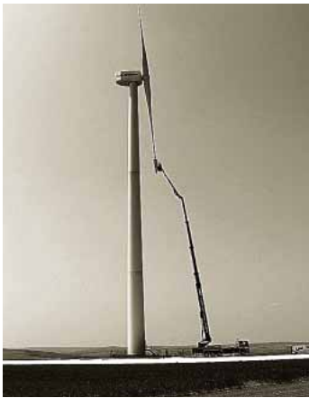
Im Windpark Dautenheim wurden die Rotorblätter repariert.
