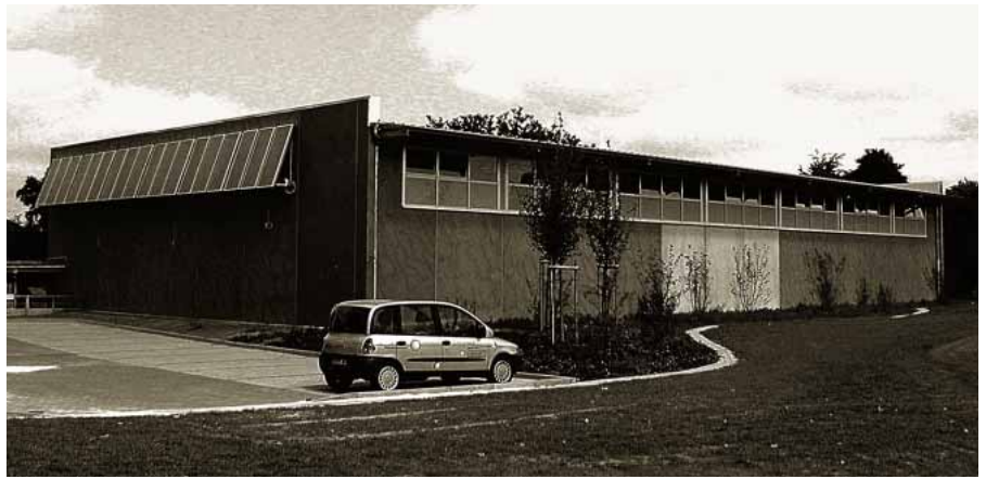
Auf dem Dach der Astrid-Lindgren-Schule soll eine Solarstromanlage entstehen.
