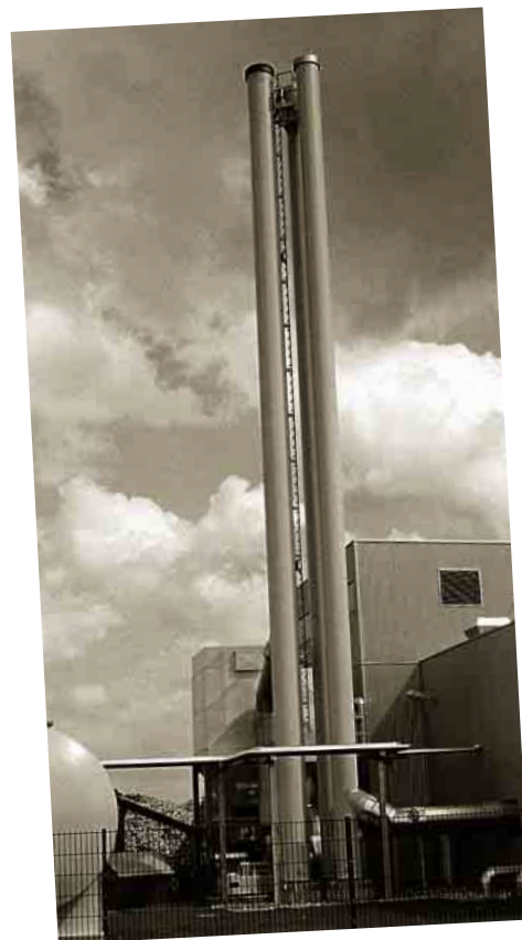
Das Biomasse-Heizkraftwerk erzeugt Energie aus Holzhackschnitzeln
