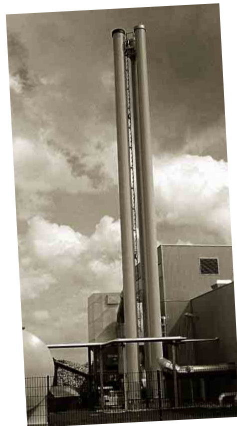
Das Biomasse-Heizkraftwerk erzeugt Energie aus Holzhackschnitzeln
