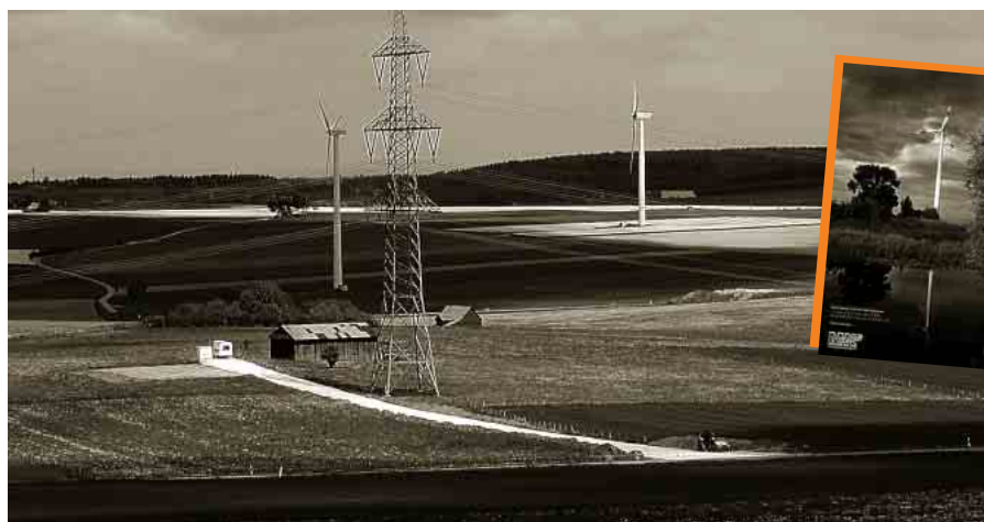
In Brilon wird bereits gebaut: im Vordergrund leuchtet der soeben fertiggestellte Weg zum künftigen Umspannwerk des neuen Projektes BürgerWIND Radlinghausen. Im Hintergrund der fünf Jahre alte Windpark Madfeld-Bleiwäsche.
