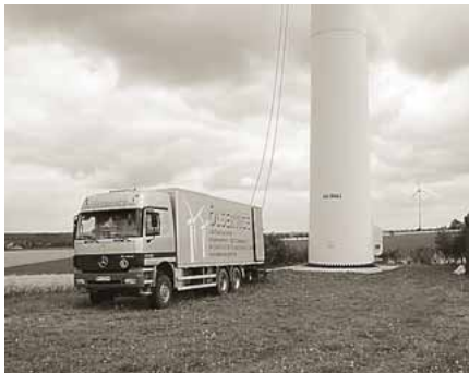
Getriebeöl-Wechsel an der N-54 in Effeln: Mit einem speziellen Pump-LKW wird über Schläuche das Altöl abgesaugt und der frische Schmierstoff direkt in die Maschinengondel befördert.
