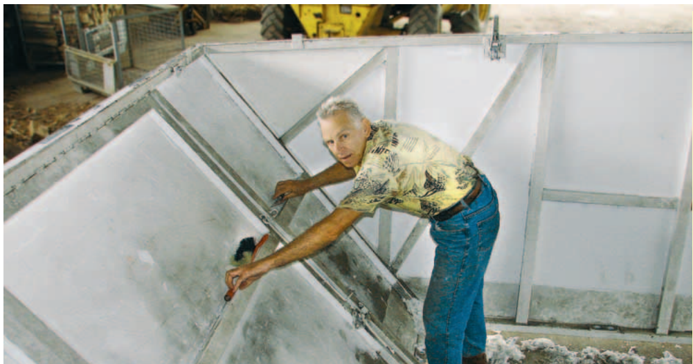
Olaf Schäfer entfernt die alte Schaumstoffauskleidung der Gondel
