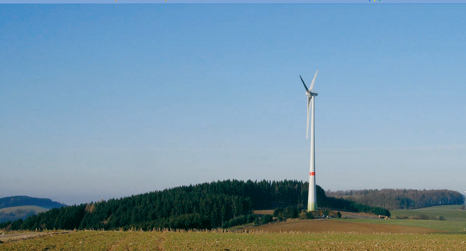
Die neue Enercon E-82 in Arnsberg-Kirchlinde: Mit einer Turmhöhe von 108 m und 82 m Rotordurchmesser gehört sie zu den größten Anlagen im Sauerland. Im Verlauf des Januar soll sie in Betrieb gehen. Mehr Bilder und Informationen auf Seite 3!
